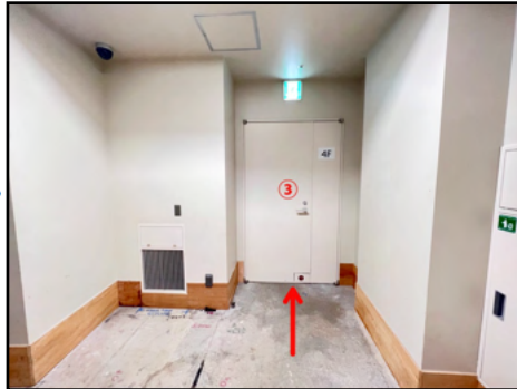
(4階エレベーターホール)
