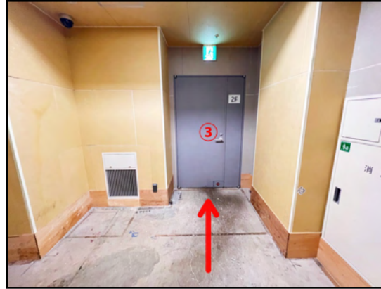
(2階エレベーターホール)
